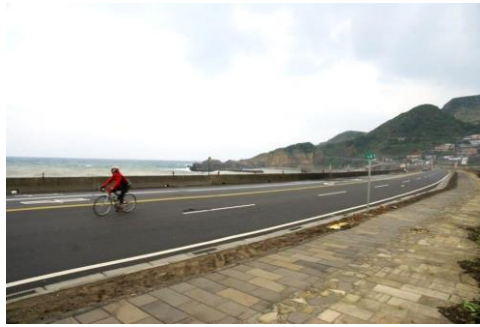
連續混凝土護欄遮蔽景觀
