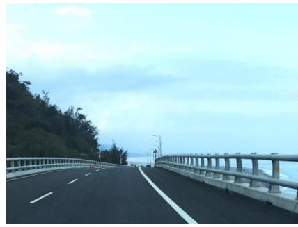
透空性護欄視域較開闊
